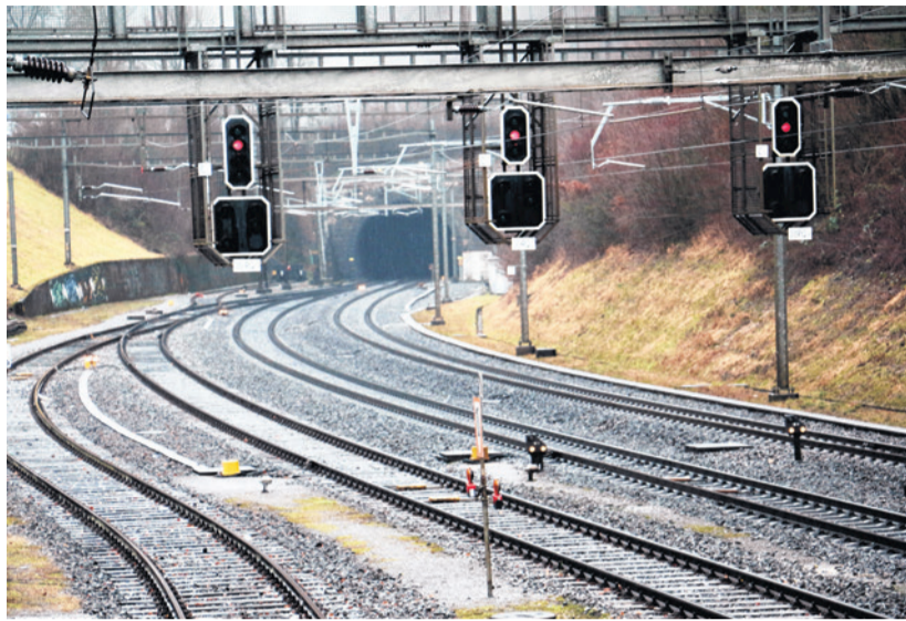
Die geplante Sanierung des Hauenstein-Basistunnels bei Tecknau hat zeitweise Teil- und Totalsperrungen zur Folge. Bild Yvonne Zollinger
